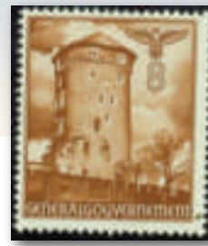
L'ancienne tour du côté Sud
